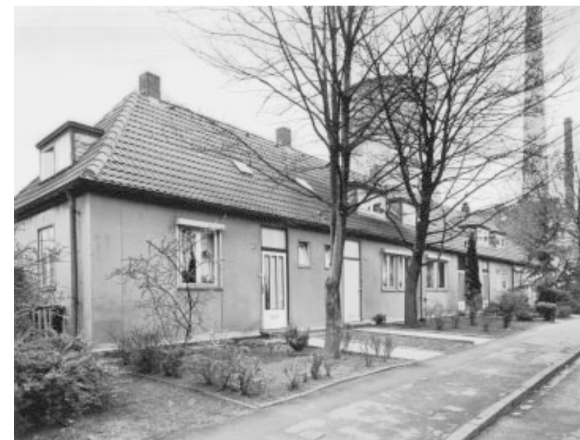
(1) Teilansicht der Stahlhaussiedlung
