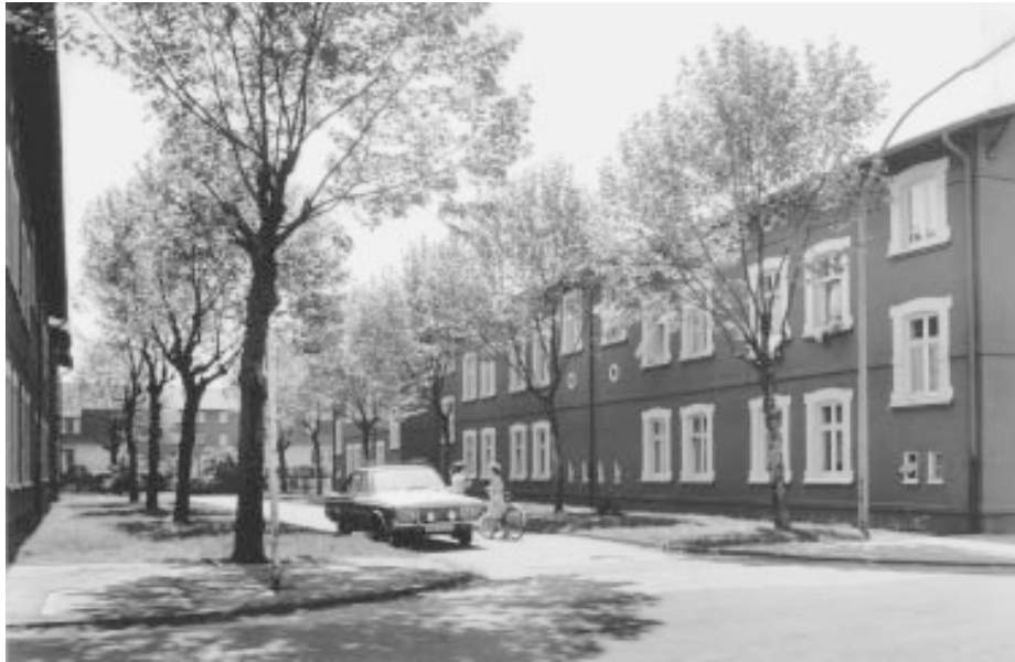
Teilansicht der Werkssiedlung der Rütgerswerke Hafenstraße, Winkelstraße Voerdestraße und Juliusstraße
